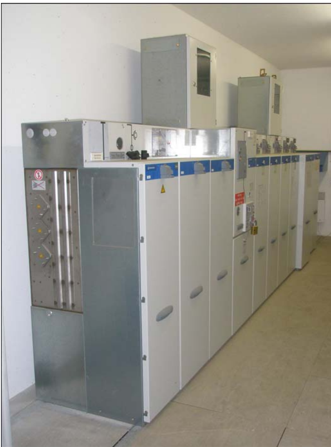
Gasisolierte Mittelspannungsanlage
