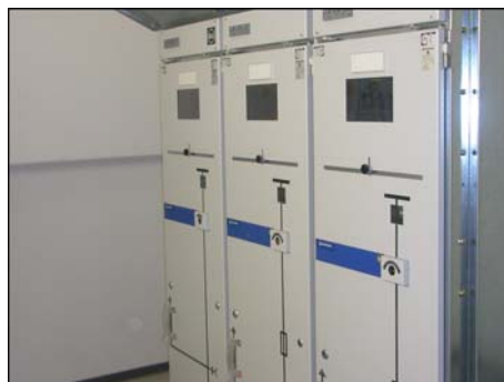
Luftisolierte Anlage
